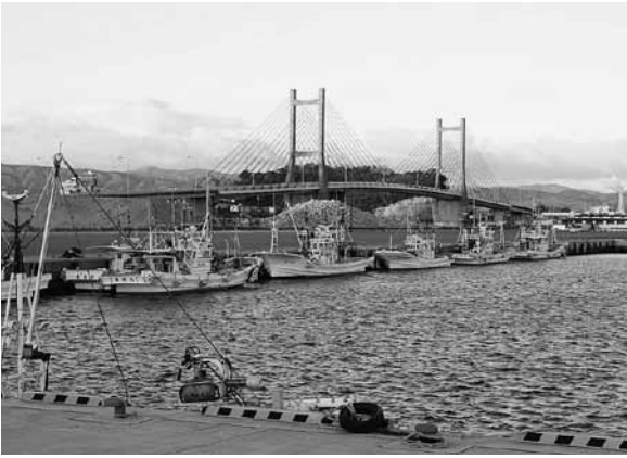
2017年春に通行を再開した松川浦大橋
